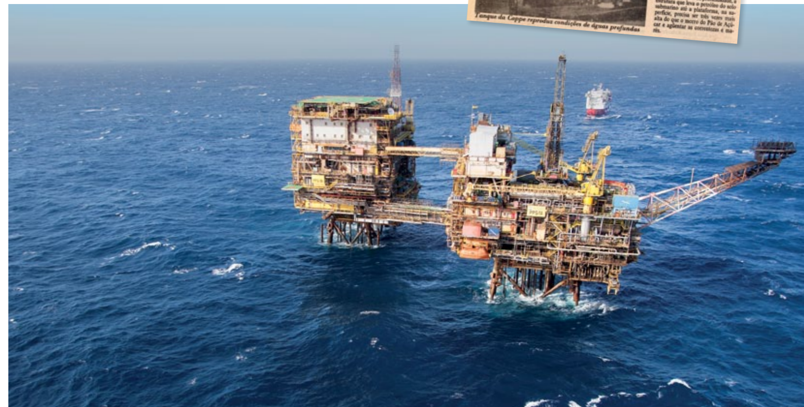
PLATAFORMA EM OPERAÇÃO NO CAMPO DE PARGO, DESCOBERTO EM 1975, NA BACIA DE CAMPOS
